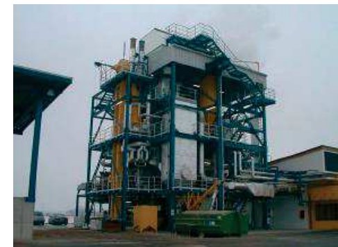
Unidade de gaseificação (Gussing)
