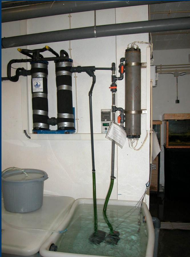
Sistema de filtração com câmara de UV
