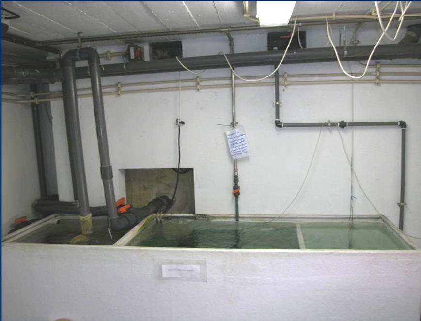
Tanque exterior para filtração biológica
