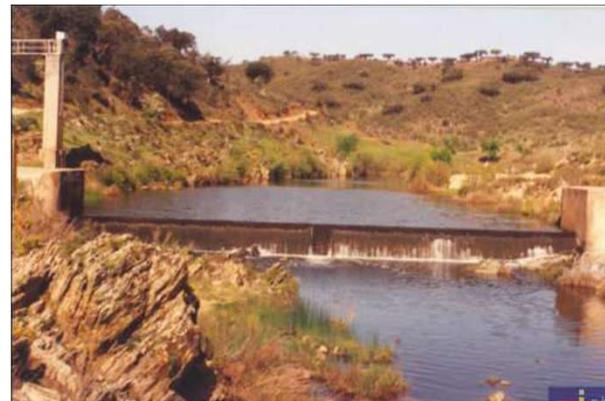
Curso de água com descarregador (esq.) e com descarregador e estação hidrométrica (dir.)
