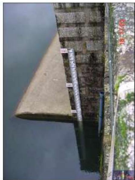
**Figura 8** Escala limnimétrica
