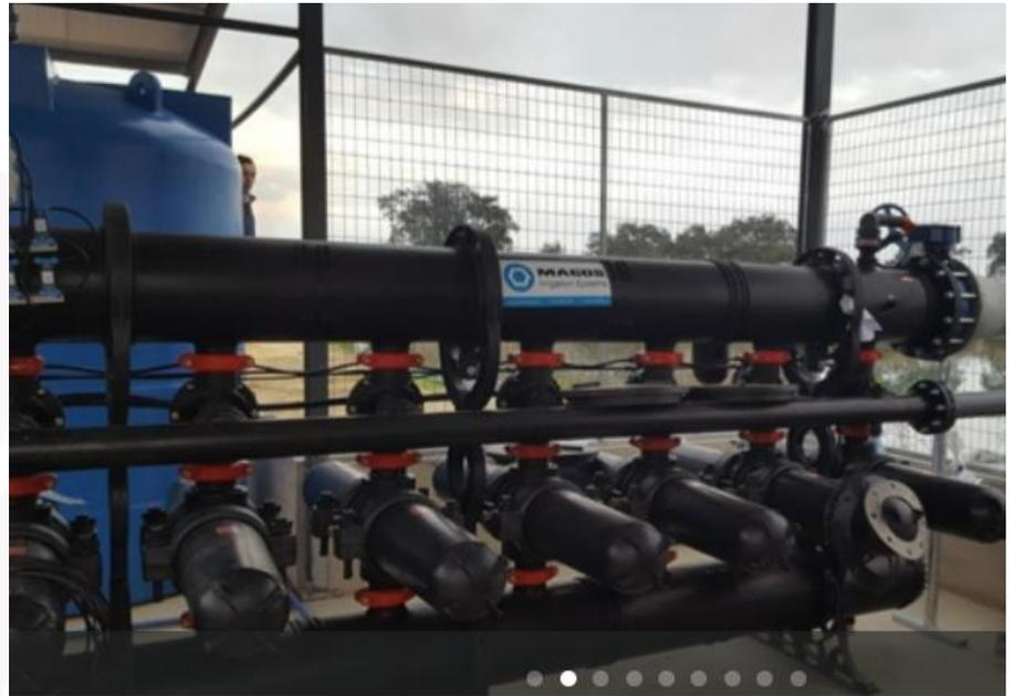
**Importante:** conhecer a capacidade de filtragem ou seja o caudal que o sistema é capaz de filtrar. A capacidade de filtragem deve ser igual ou superior ao caudal máximo que circula no cabeçal de rega
