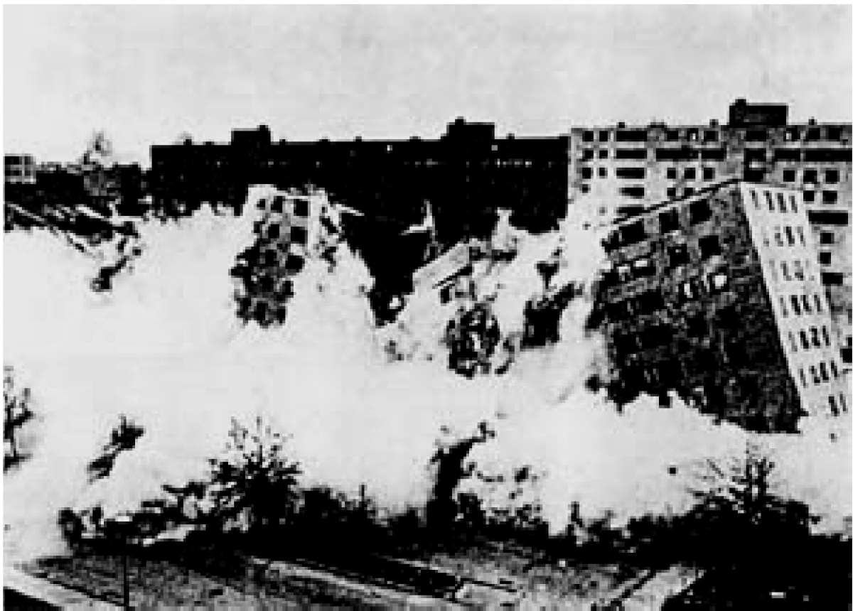
Explosão do Conjunto Residencial Pruitt-Igoe - St. Louis (1972)
