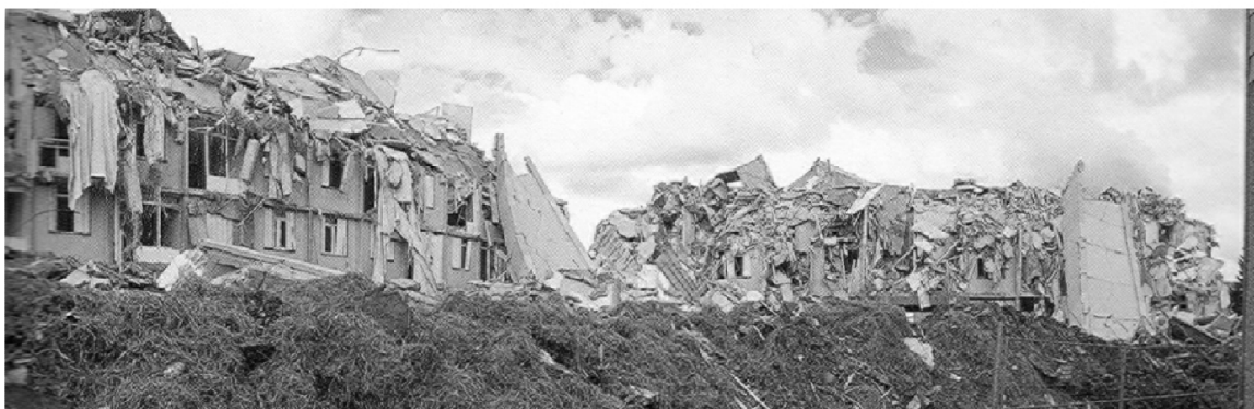
Marin Kasimir - Démolition d'un HLM à Argonne (1993)
