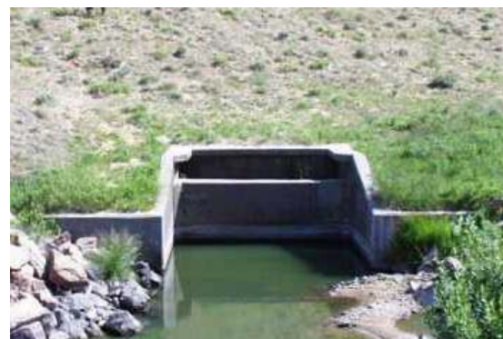
Figura 15 – Bacia de dissipação por impacto (Peterka, 1978). Perspectiva com canal trapezoidal a jusante e foto.
