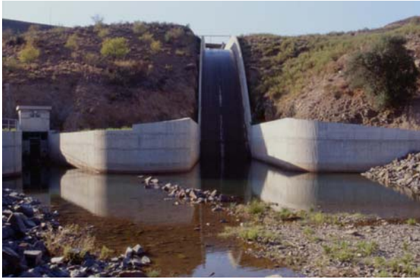
Figura 3 – Barragem do Beliche. Vista de jusante dos muros-ala da bacia de dissipação de energia.
