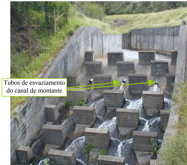
Figura 14 – Central termoelétrica do Pego. Rampa de blocos.
